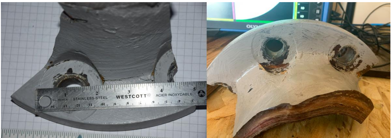
Figure 2. Fissure entre les trous de boulon dans un échantillon découpé dans une bride en FRP
